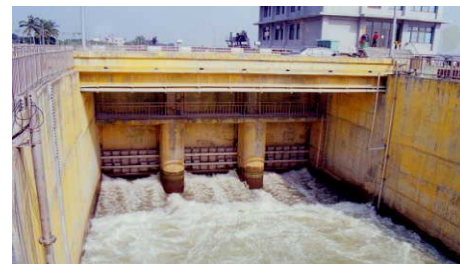
圖 3 放水路閘門放流情形
