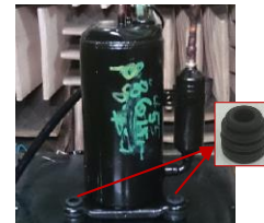
圖 1 迴轉式壓縮機之橡膠墊示意圖
