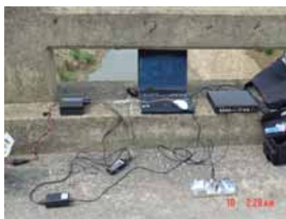
圖 1、保力橋振動儀器架設圖
